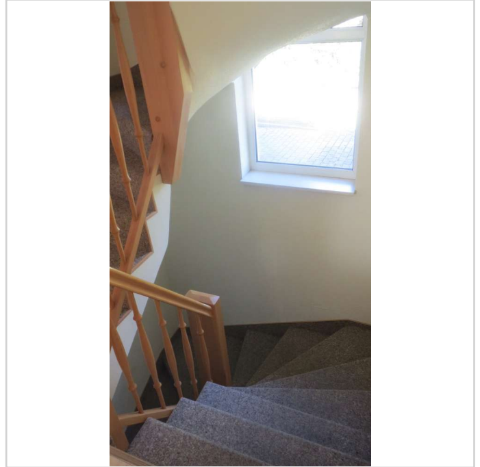
EG Treppe zum UG
