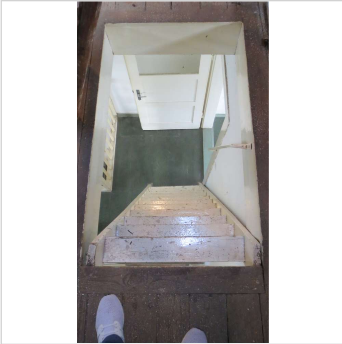
Boden Treppe z.DG
