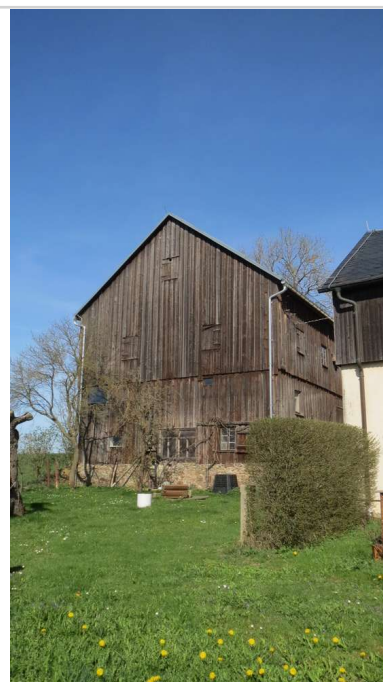
Scheune von SÜD
