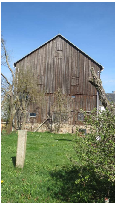
Scheune von SÜD (2)
