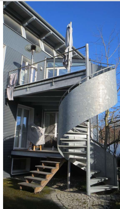
Treppe zum Garten
