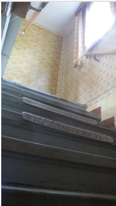
EG Treppe OG
